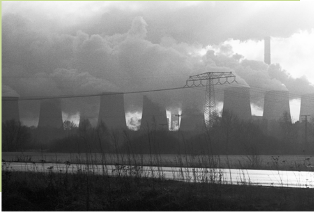
Verbrennung von Braunkohle. Die Energiebilanz des Rohstoffs war ineffizient: 80 Prozent gingen bei der Nutzung verloren. © Bundesstiftung Aufarbeitung, Klaus Mehner, 88_1208_WIF_BKohle_26
